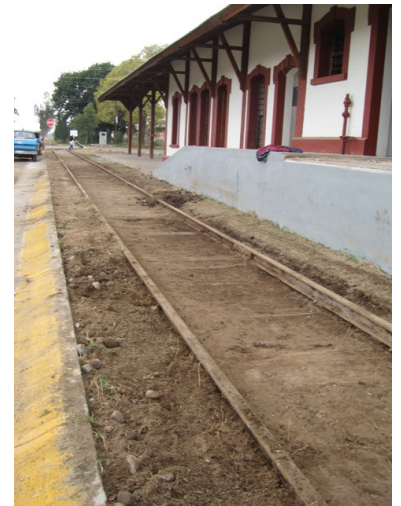
Trabajos de limpieza de vía ferrea en Corredor "La Estación"
