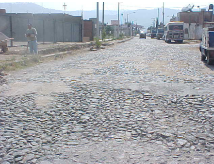
Trabajos de empedrado a vialidades
