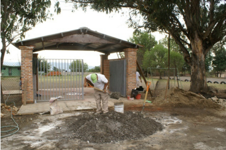
Construcción de pórtico en escuela primaria de El Fresnito
