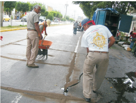
Trabajos de calafateo en Calzada Madero y Carranza
