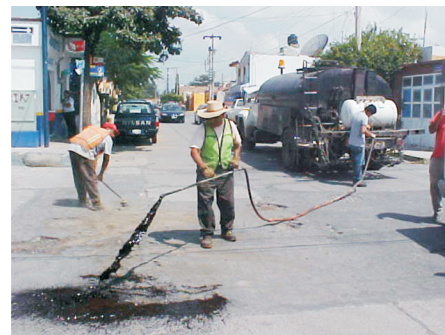
Trabajos de bacheo
