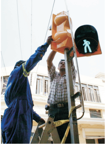
Instalación de semáforo peatonal en calle Reforma
