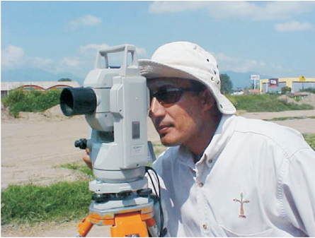
Trabajos de topografía y nivelación
