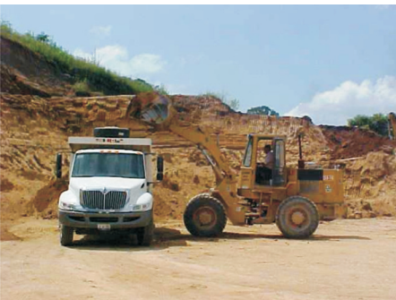
Carga y transporte de materiales
