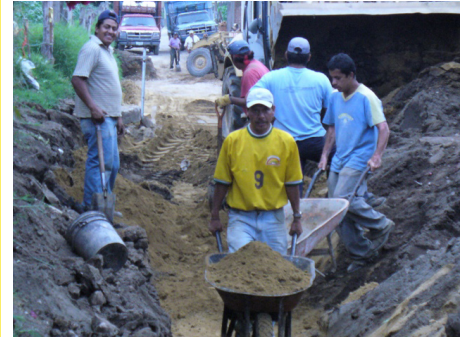
Trabajos de obras públicas en la colonia Leyes de Reforma
