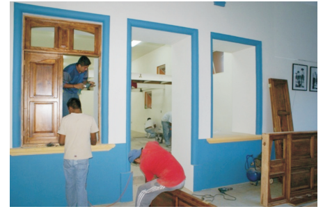
Construcción de las nuevas oficinas del departamento de Hacienda Municipal
