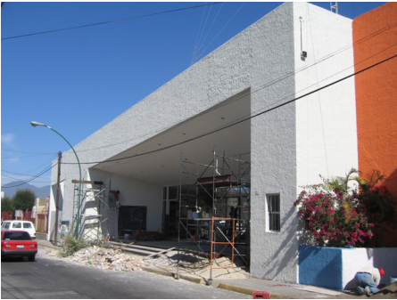
Rehabilitación del edificio de Casa de la Cultura
