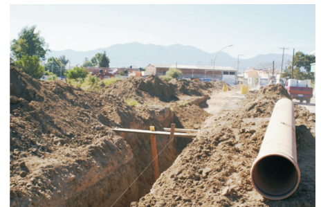
Constructor de colector “Alberto Cárdenas Jiménez”
