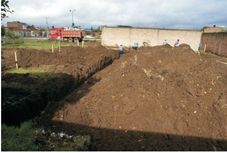
Arranque de obras del CADI con apoyos del Programa HABITAT 2007
