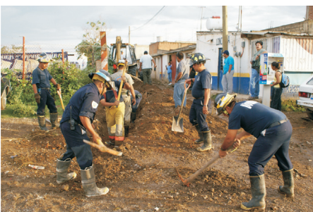
Trabajos en la colonia Leyes de Reforma, por motivo de inundación
