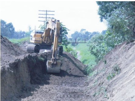
Trabajos en el canal Volcanes
