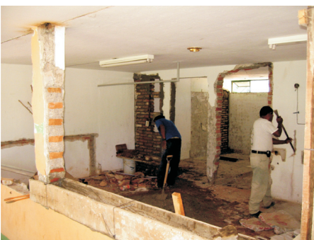
Trabajos de rehabilitación en la unidad deportiva "Venustiano Carranza"
