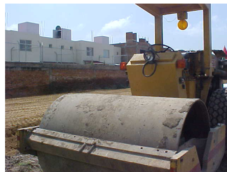
Trabajos de compactación de balastre
