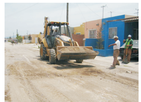
Mantenimiento a vialidades de la colonia La Providencia
