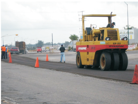
Asfaltado en tramo La Estación
