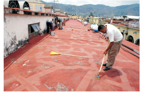
Trabajo de impermeabilización del techo del Mercado “Paulino Navarro”
