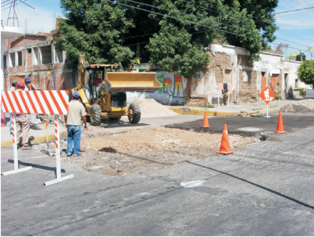
Trabajos de nivelación a vialidades
