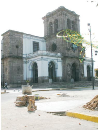
Construcción de rampas en el Jardín Principal
