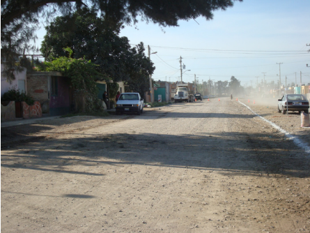
Trabajos en la calle Carlos Páez Stille
