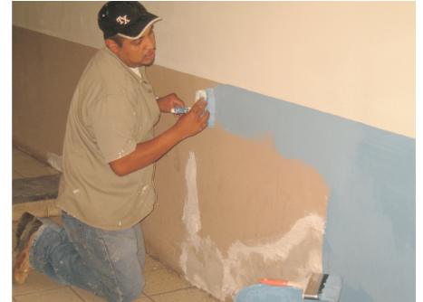
Mantenimiento a paredes del edificio de Presidencia
