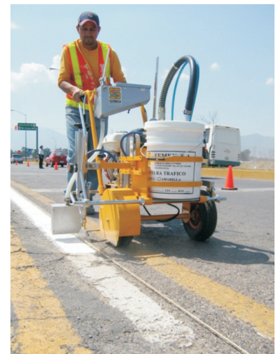
Trabajos con máquina pinta rayas
