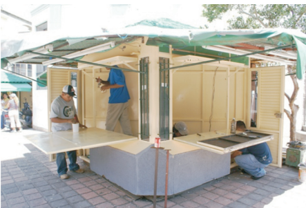
Trabajos de pintura en los Kioscos
