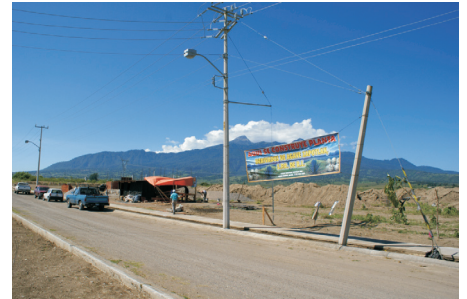
Construcción de la empresa Derivados de Agave de Zapotlán
