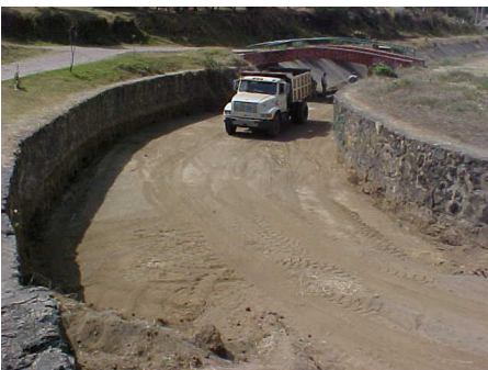
Trabajos de limpieza del canal hidrológico
